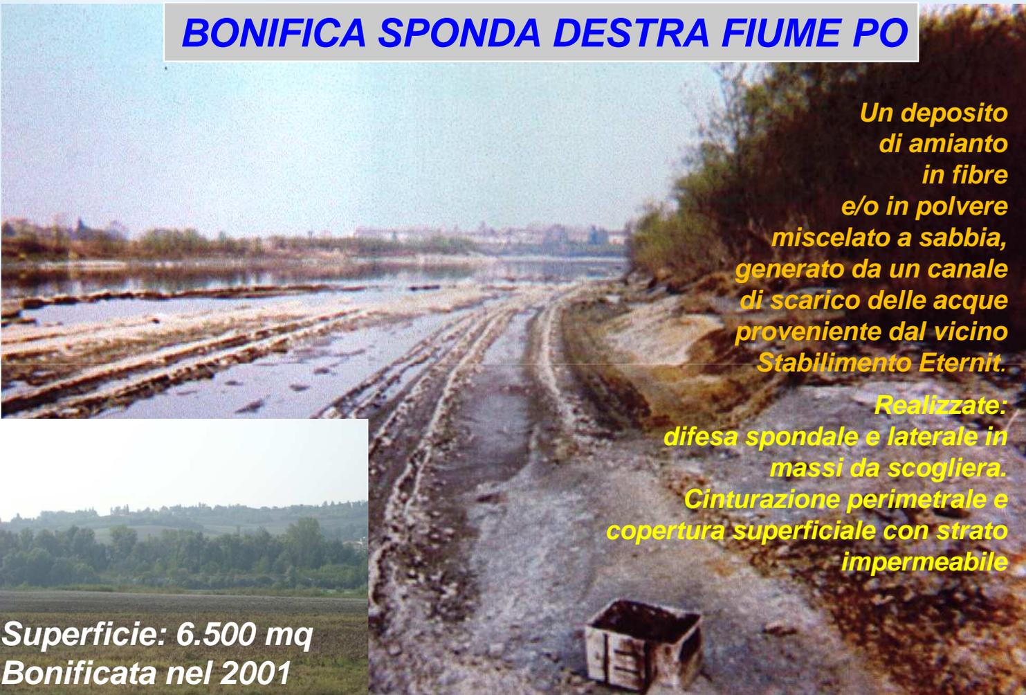
**Un deposito di amianto in fibre e/o in polvere miscelato a sabbia, generato da un canale di scarico delle acque proveniente dal vicino Stabilimento Eternit.**
